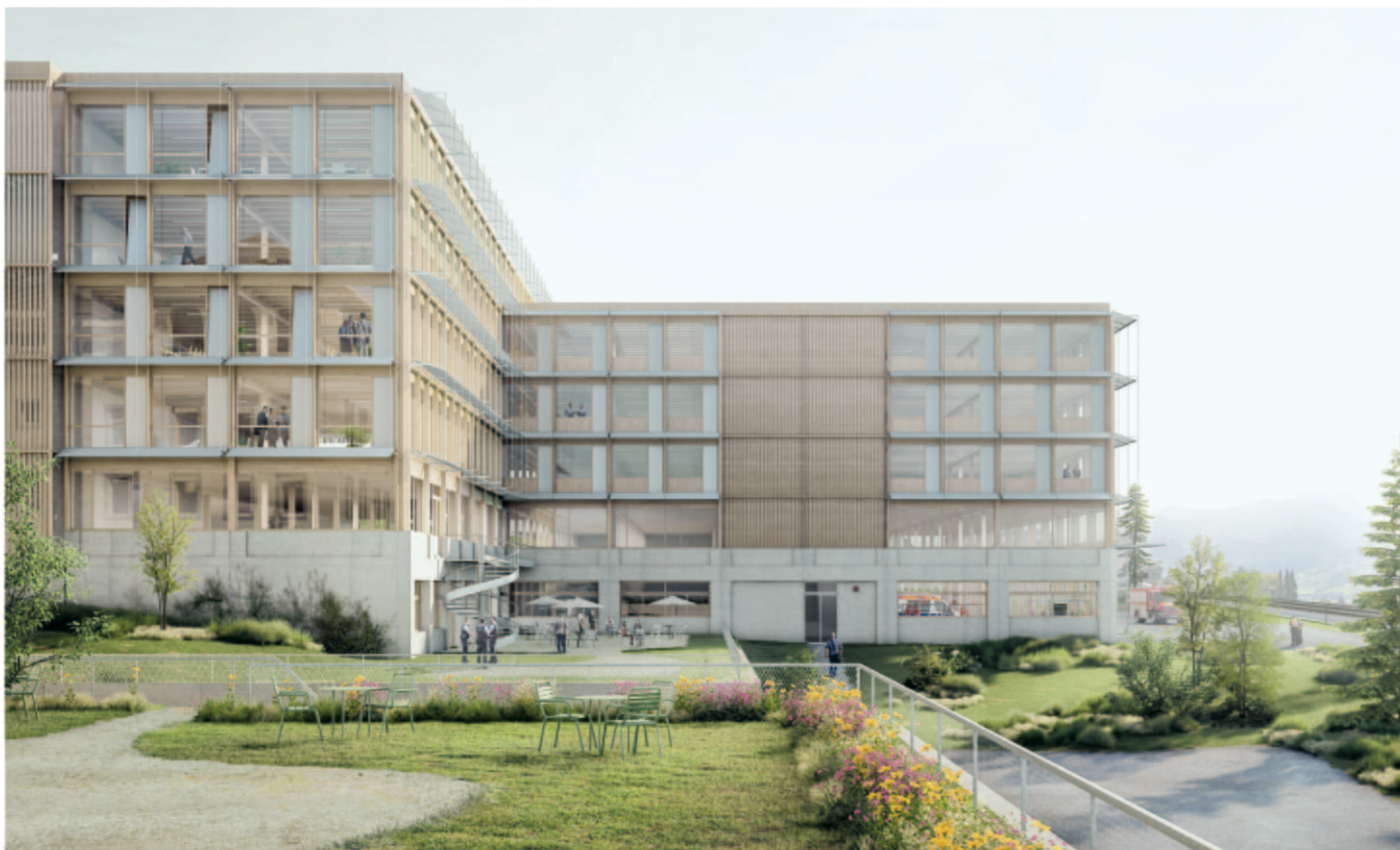
Vorfabrizierte Holzmodulfassade mit einem Glasanteil von 50 %
