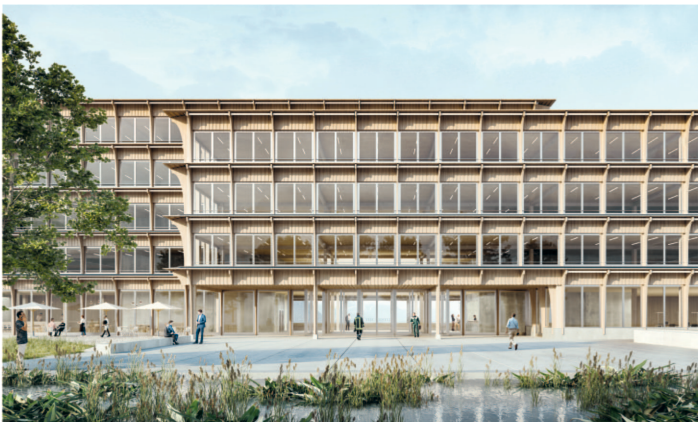
Die Staffelung des Volumens und die Holzkonstruktion in Form einer räumlichen Fassade bestimmen die äussere Erscheinung.
